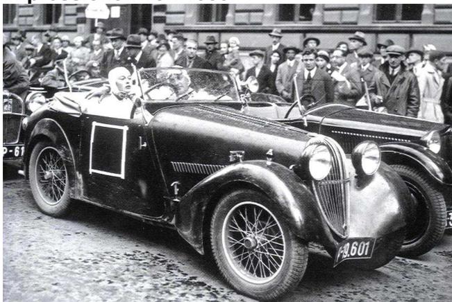
In der Klasse bis 1100 cm<sup>3</sup> startete fast durchwegs Fahrzeuge mit 2-Takt-Motor: Im Vordergrund ein Aero 1000 Spezial mit Hinterradantrieb – daneben ein Z-4-Roadster mit dem damals noch (1933 vorgestellt) neuen Vorderradantrieb.
